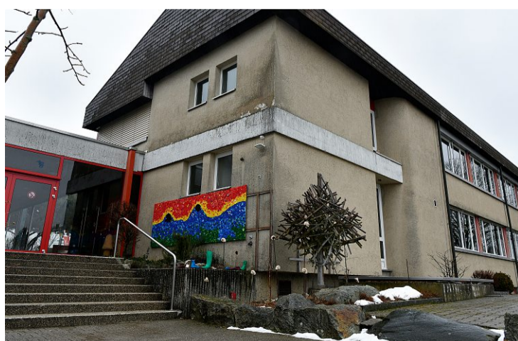
Die neue Klasse wird im Schulhaus eröffnet, der Kindergarten zieht in Containermodule daneben. Foto: Thomas Peter
